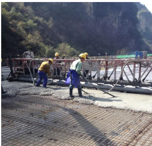
混凝土浇筑
