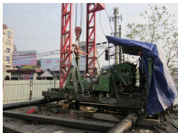
回旋钻施工钻孔桩
