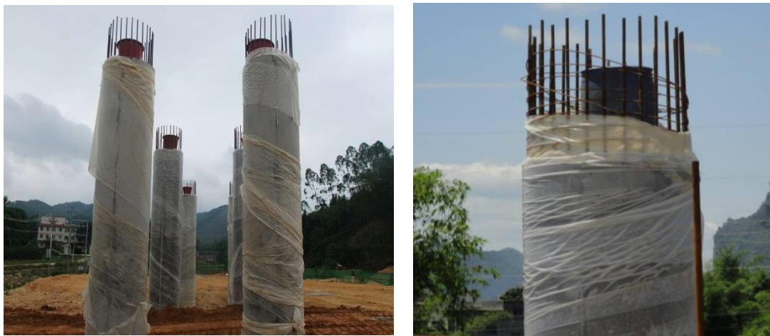
墩柱混凝土养护示意
