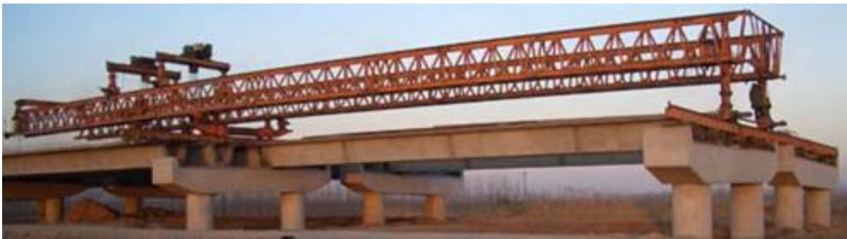
双导梁架桥机架梁示意
