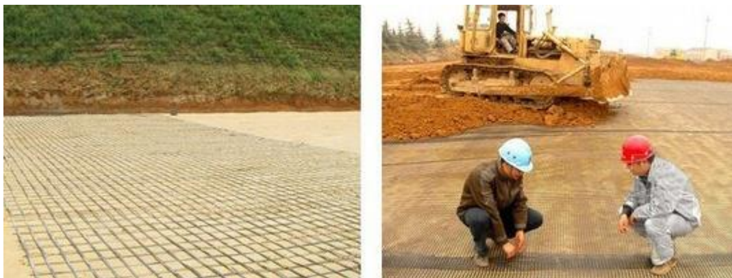
土工格栅施工
