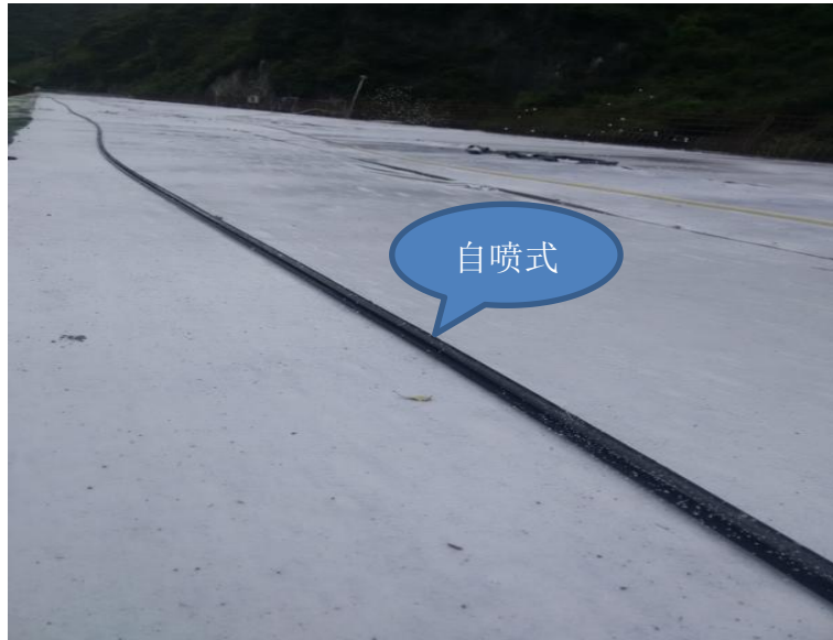
桥面铺装养生
