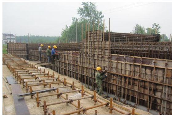
通道模板安装
