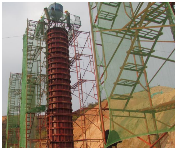
墩柱施工施工爬梯示意
