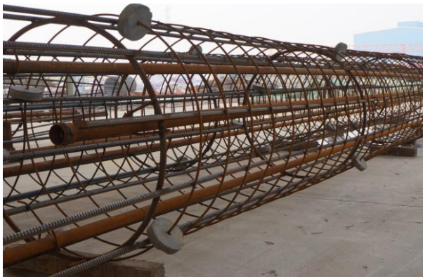
钢筋笼保护层垫块图
