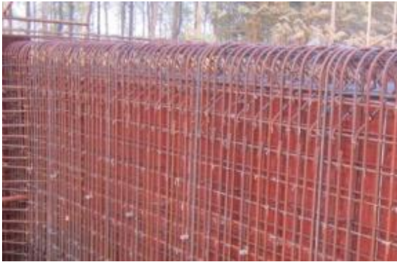
箱涵、通道钢筋安装
