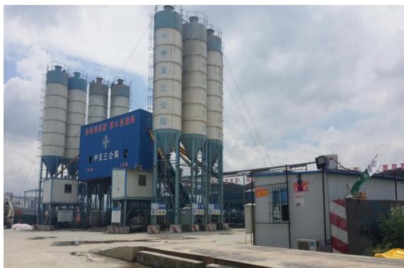
混凝土拌和站图
